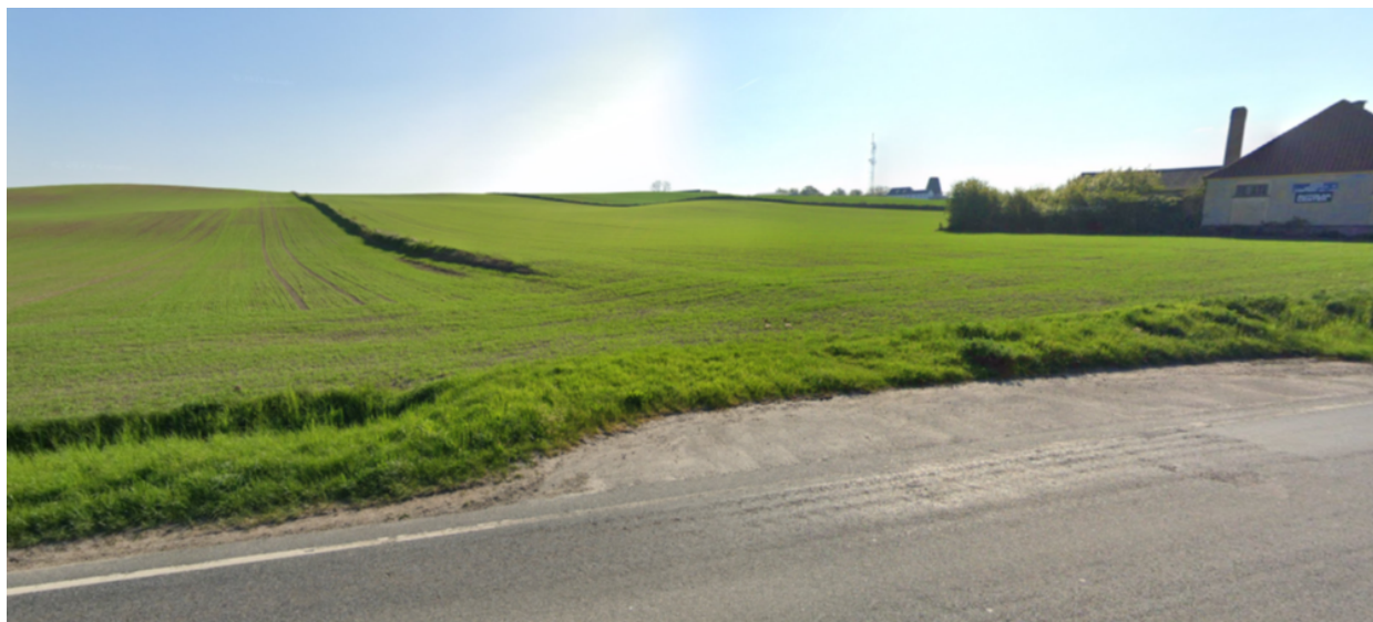
Figur 3. Dige D00.013.307 og digegennembrud mellem matr. 3c og 40d. (Google Street View maj 2023)
