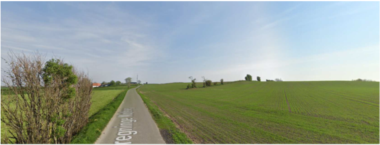
Figur 6. Digegennembrud i D00.013.334 (Google Street View maj 2023)
